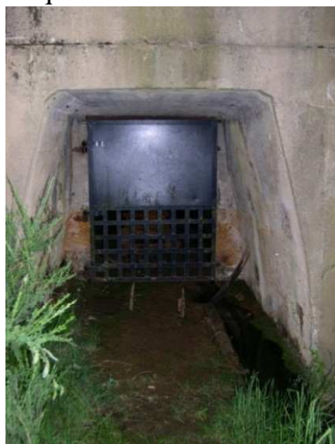
Système de fermeture avant les travaux
