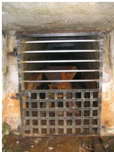
Système de fermeture après les travaux
