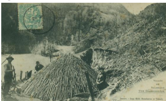
Charbonnage en vallée de Valbeix (Puy-de-Dôme)
